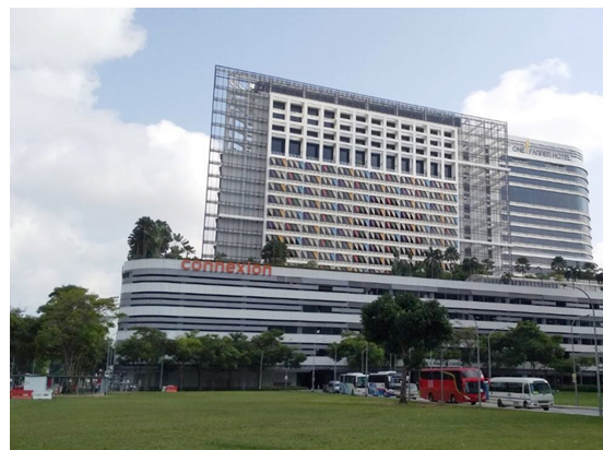
写真4 この建物の左側は病院(病棟)、右側はホテル機能を併せ持つ
