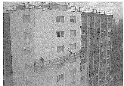
【写真5】壁面の断熱改修(リヨン)
