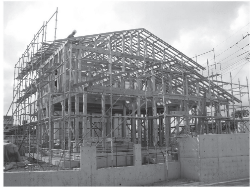
図4) 木造軸組 (引用： http://www.koukenhome.jp/house-manual/2098.php )
